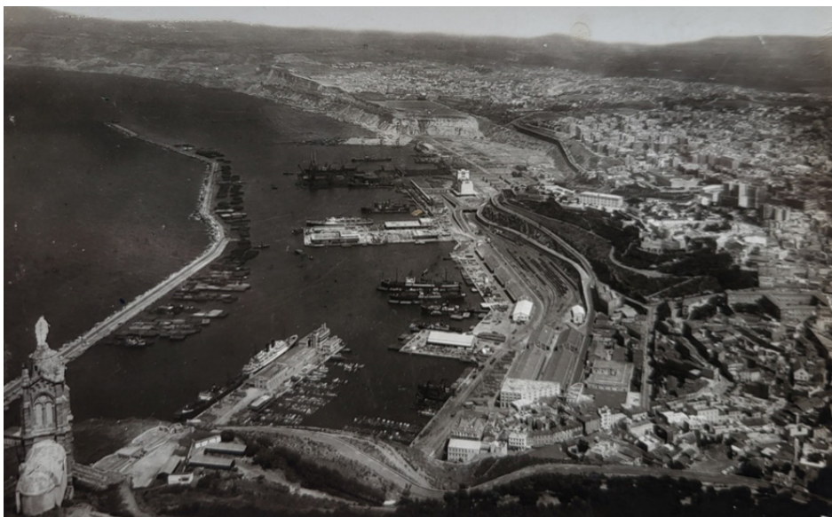
Foto 4: Puerto de Orán. Fuente: Tarjeta postal antigua.
